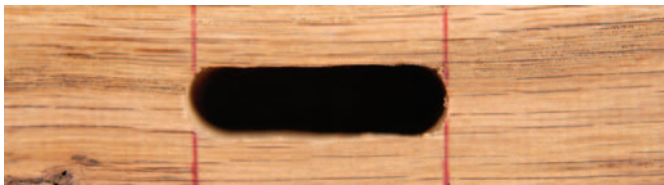
Mortaise respectant le tracé. L'assemblage sera solide.
