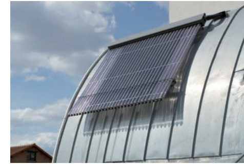
L'inclinaison à 60° et l'orientation sud-sud-est des capteurs à tubes permet de bénéficier d'un ensoleillement maximal.
